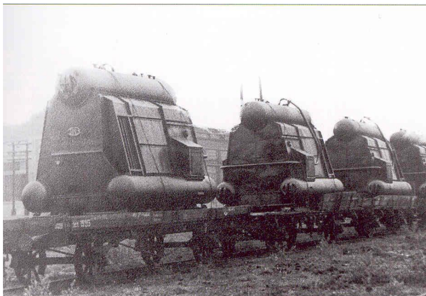
Транспортировка трех барабанных паровых котлов
