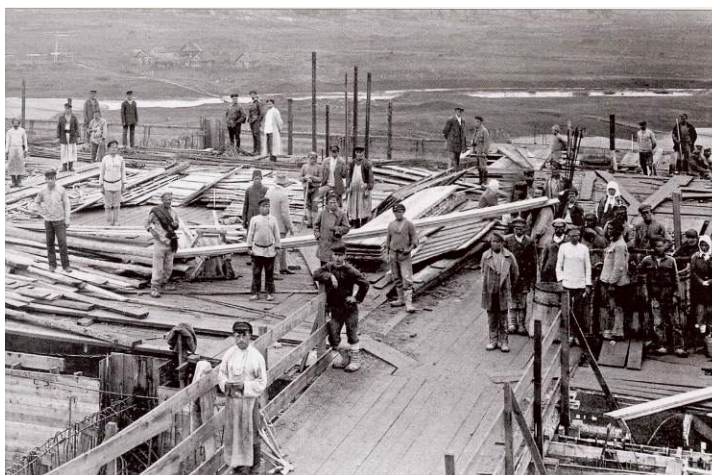
Строительство Нижегородской ГРЭС. 1921 г.
