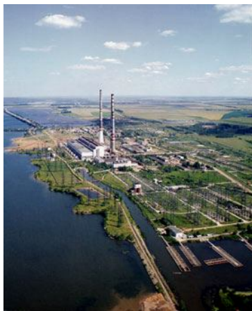
Пущена Кармановская ГРЭС на газомазутном топливе в Башкирской АССР.
