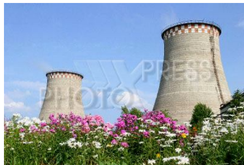
Градирни Северной ТЭЦ
