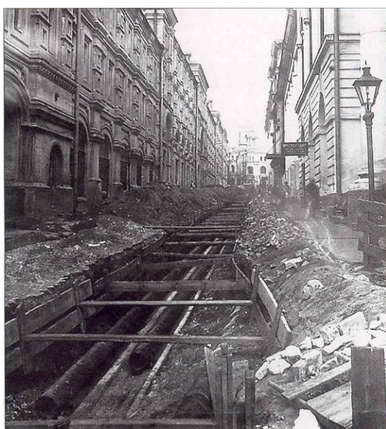
Прокладка теплопровода по Хрустальному переулку в Москве (начало 30-х годов)
