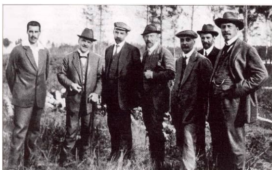
Руководители строительства станции "Электропередача".
